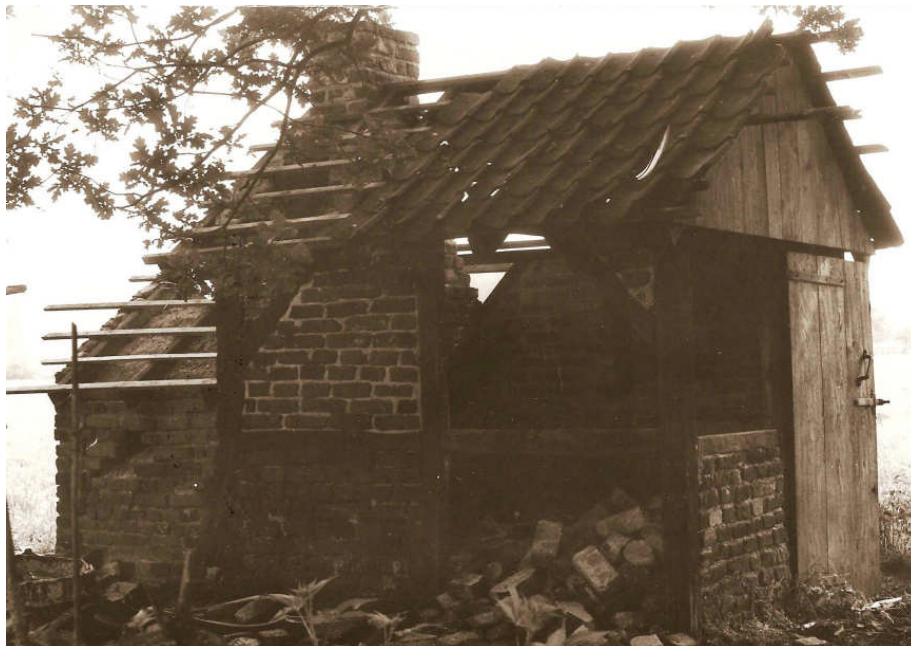
Das Barmseidsche Backhaus vor dem totalen Verfall 1970
